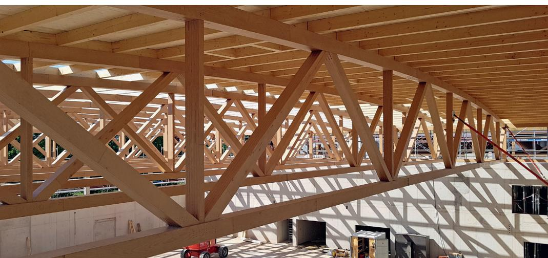
Einsatz von BauBuche beim Dach-Tragwerk einer Sporthalle in Langenhagen bei Hannover.
